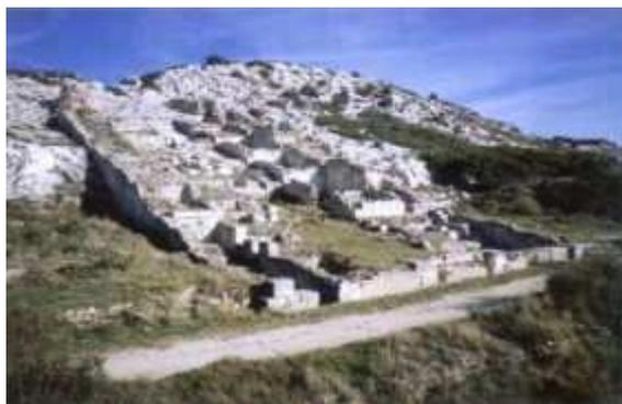
L'aqueduc et les moulins de Barbegal constituent un complexe romain hydraulique situé à Fontvieille, à proximité d'Arles, composé de deux aqueducs parallèles, l'un conduisant l'eau potable vers l'agglomération et le second alimentant un ensemble de meunerie composé de deux fois huit roues à aubes qui fournissaient l'énergie à des moulins à farine.
