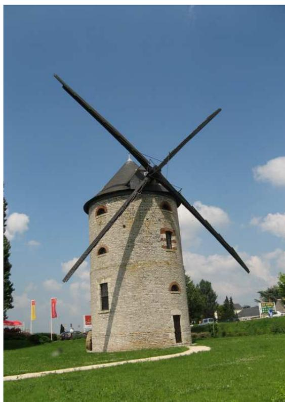
D'une hauteur totale de 16 mètres, coiffé d'une toiture tournante d'un poids de 15 tonnes commandée manuellement de l'intérieur, il tourne ses ailes de 21,40 m à commande d'ouverture réglable système Berton\*.
