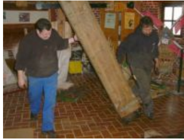
l'arbre est guidé du rez-de-chaussée et ensuite sorti du moulin
