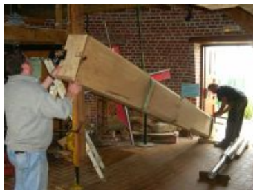
la deuxième partie de l'arbre en chêne est montée et assemblée avec les deux autres parties l'arbre de lanterne est reconstitué et les trois parties sont assujettis par deux boulons
