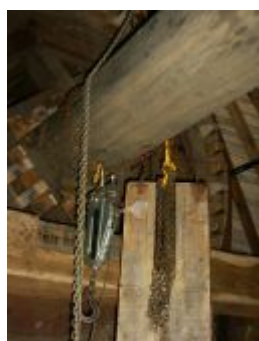
au 1er étage, les vis et clavettes de calage du hérisson sont enlevées
