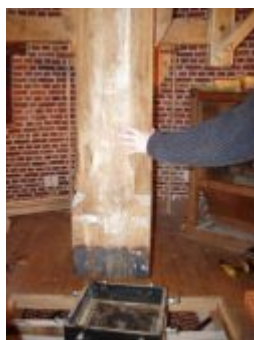
au 2ème étage, l'arbre vertical est dégagé de la pièce de liaison et relevé jusqu'au 3ème étage à l'aide de chaînes
