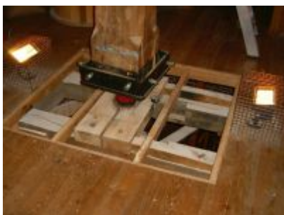
au deuxième étage, le calage de la pièce de liaison entre l'arbre en bois et l'arbre en fonte, en dessous, est enlevé
