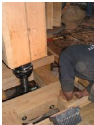
le nouveau support au niveau du plancher du deuxième étage
