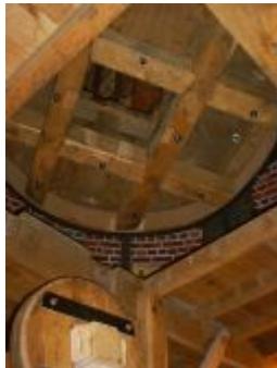
le plancher du 3ème étage a été ouvert, la lanterne est "en l'air"
