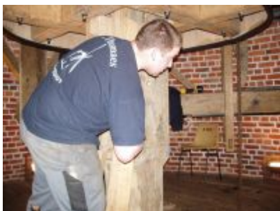
au 3ème étage, le calage de la lanterne sur l'arbre vertical est enlevé
