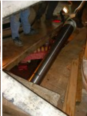
l'arbre de hérisson est hissé au premier étage et va être inséré dans le hérisson posé sur les coffres des meules
