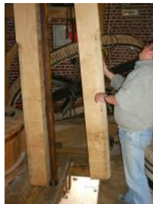
l'âme en acier est montée et placée dans le logement de l'arbre en chêne
