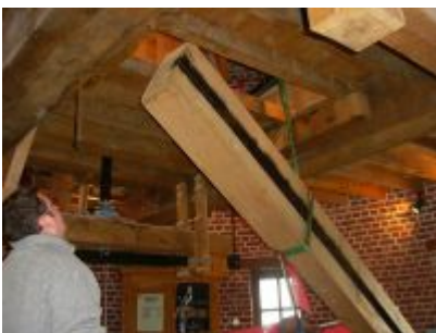
la montée de la première partie de l'arbre en chêne (le passage entre les poutres est "juste" !)
