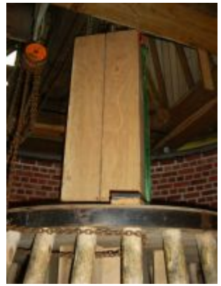
les différentes étapes de la montée de l'arbre de lanterne vers le deuxième étage
