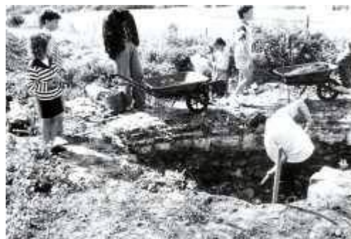
L'association "La Tourelle", en juillet-août 1991, a organisé des chantiers jeunes qui ont mis à jour les anciennes fondations du moulin. (bulletin municipal de décembre 1991)
