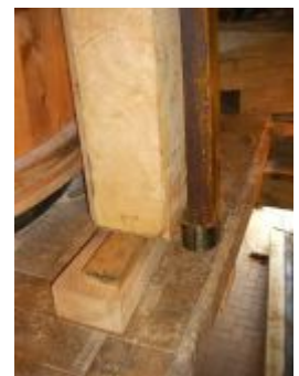
l'âme en acier est montée et placée dans le logement de l'arbre en chêne
