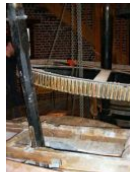
le hérisson est descendu à l'aide d'un câble et d'un treuil
