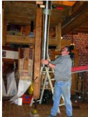
l'arbre de hérisson est hissé au premier étage et va être inséré dans le hérisson posé sur les coffres des meules
