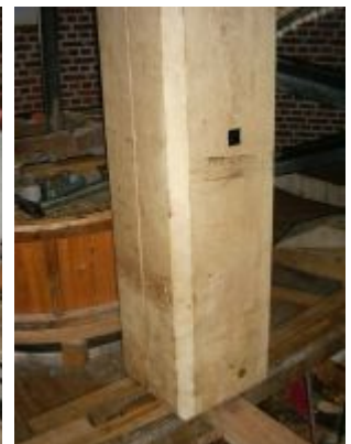
l'âme en acier est montée et placée dans le logement de l'arbre en chêne
