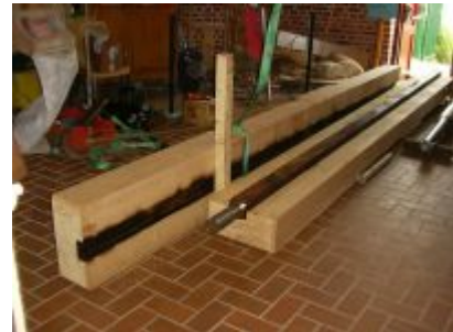
La particularité de ce nouvel arbre est son "âme" en acier de section carrée enchâssée dans deux parties en chêne
