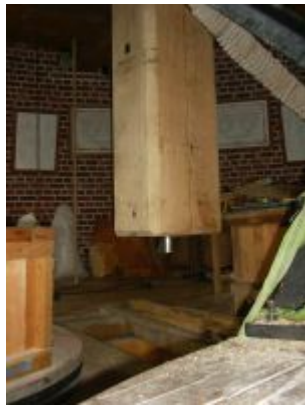
les différentes étapes de la montée de l'arbre de lanterne vers le deuxième étage
