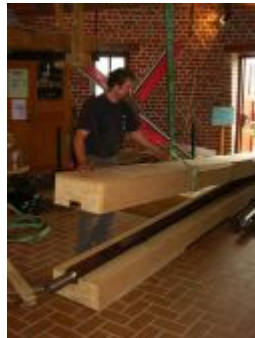
La particularité de ce nouvel arbre est son "âme" en acier de section carrée enchâssée dans deux parties en chêne
