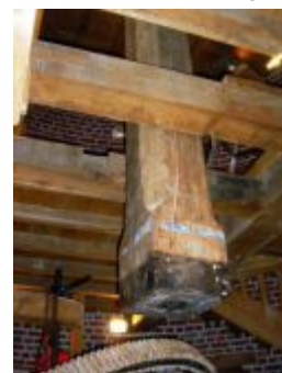
au 2ème étage, l'arbre vertical est dégagé de la pièce de liaison et relevé jusqu'au 3ème étage à l'aide de chaînes
