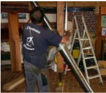
l'arbre de hérisson est hissé au premier étage et va être inséré dans le hérisson posé sur les coffres des meules
