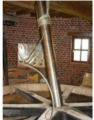
l'arbre de hérisson est hissé au premier étage et va être inséré dans le hérisson posé sur les coffres des meules
