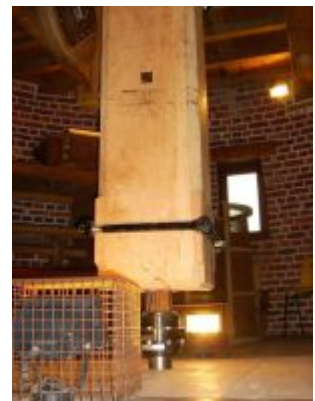
le nouveau support au niveau du plancher du deuxième étage
