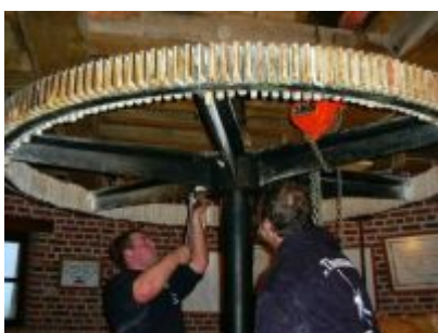
au 1er étage, les vis et clavettes de calage du hérisson sont enlevées
