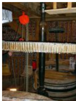
le hérisson est descendu à l'aide d'un câble et d'un treuil
