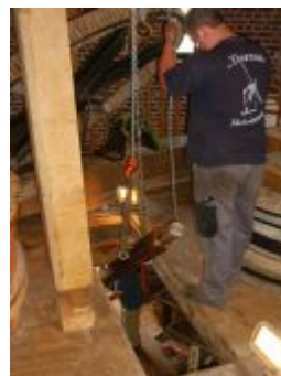
l'âme en acier est montée et placée dans le logement de l'arbre en chêne
