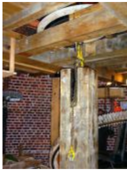
l'arbre en chêne descend du 3ème étage, de la couronne du tire-sacs au travers de la lanterne
