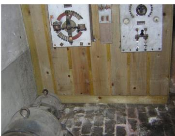
A Saint-Félix, un générateur (dynamo) produisait du courant en 110 volts continu pour l'éclairage des ateliers et de la maison du maître. Par la suite, l'adjonction d'un alternateur a permis d'obtenir du courant électrique alternatif. Le mécanisme hydraulique alimente aujourd'hui un alternateur en 380 volts et fournit une puissance de 10 KW / heure. L'alimentation par EDF n'est arrivée sur le site qu'en 1986.
